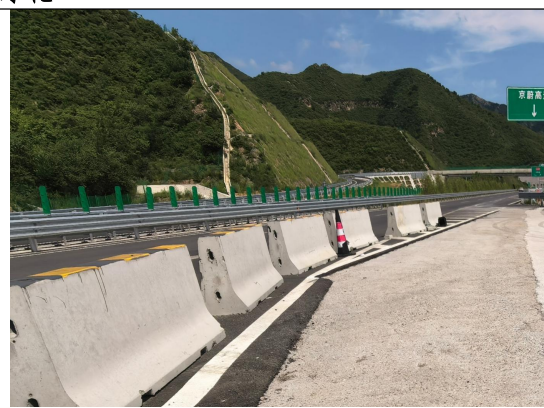
临时堆土区恢复后照片
